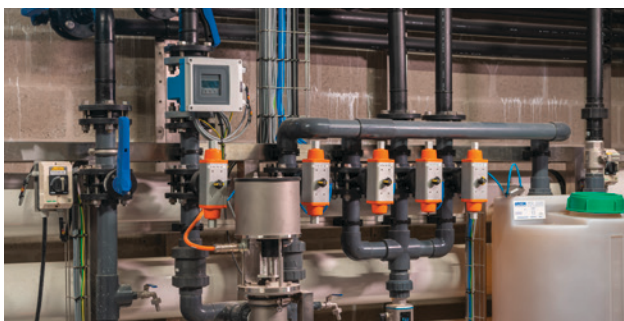
Absperrklappen mit pneumatischen oder elektrischen Antrieben werden als Prozess- und Regelarmaturen eingesetzt.
