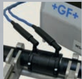
Impostare parametri di saldatura e saldare
