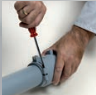
Inserire il tubo nel raccordo e serrare le viti
