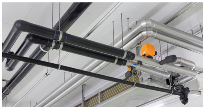
Tous les composants du système de refroidissement des tubes sont déjà pré-isolés.
