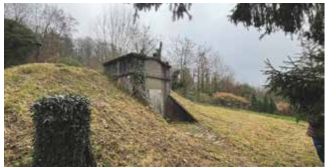
Druckminderstationen wie „Am Geisrech“ regulieren den Wasserdruck. Sie sorgen dafür, dass angeschlossene Geräte oder Systeme mit einem konstanten sowie sicheren Druck arbeiten und schützen diese damit vor möglichen Schäden. Foto: Thierberger (GWK)
