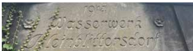
Die Einhausung der ehemaligen Trinkwasserkammer feierte bereits vor zehn Jahren ihr 100jähriges Bestehen. Foto: Thierberger (GWK)
