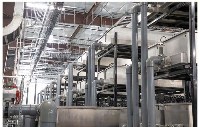
ChlorFIT, en CPVC Corzan®, est un système de tuyauterie Schedule 80 très robuste et résistant à la corrosion qui offre une fiabilité supérieure et des performances durables dans les applications commerciales et industrielles.
